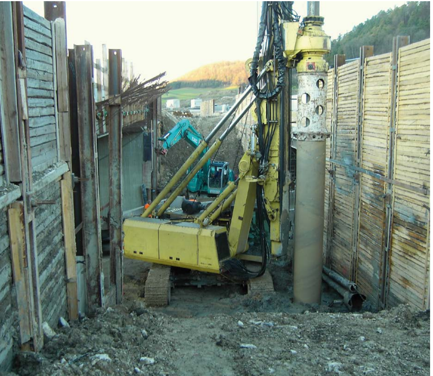
Baugrube Unterführung „Inselbaustelle“
