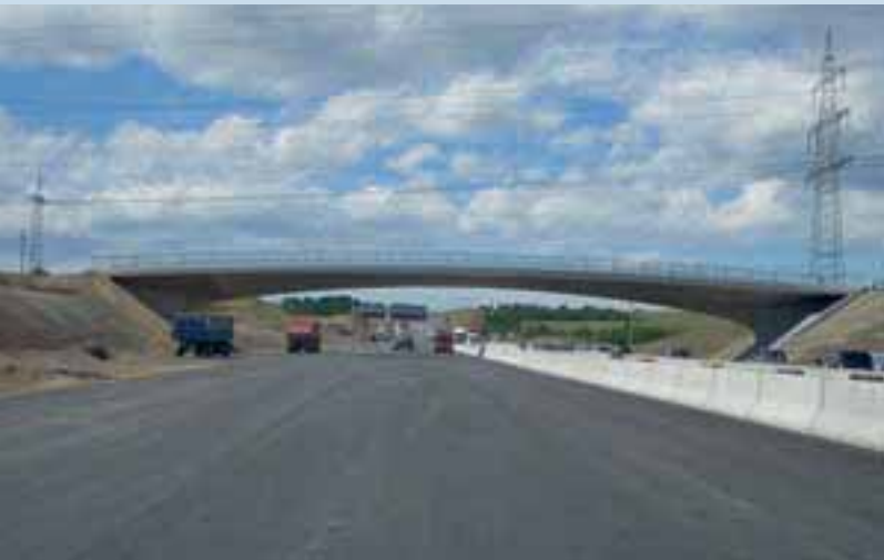
Einfeldrahmenbrücke mit gekrümmtem Grund- und Aufriss.
