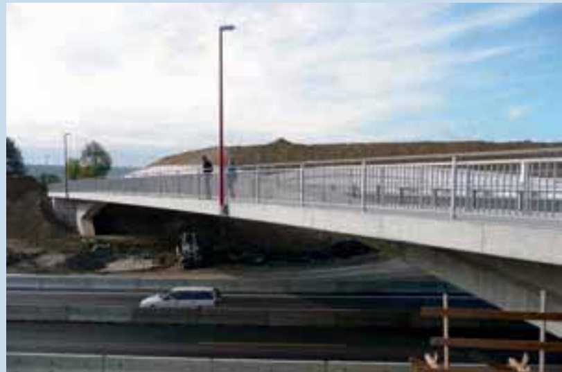
Überführung K 1012, Ansicht Ost
