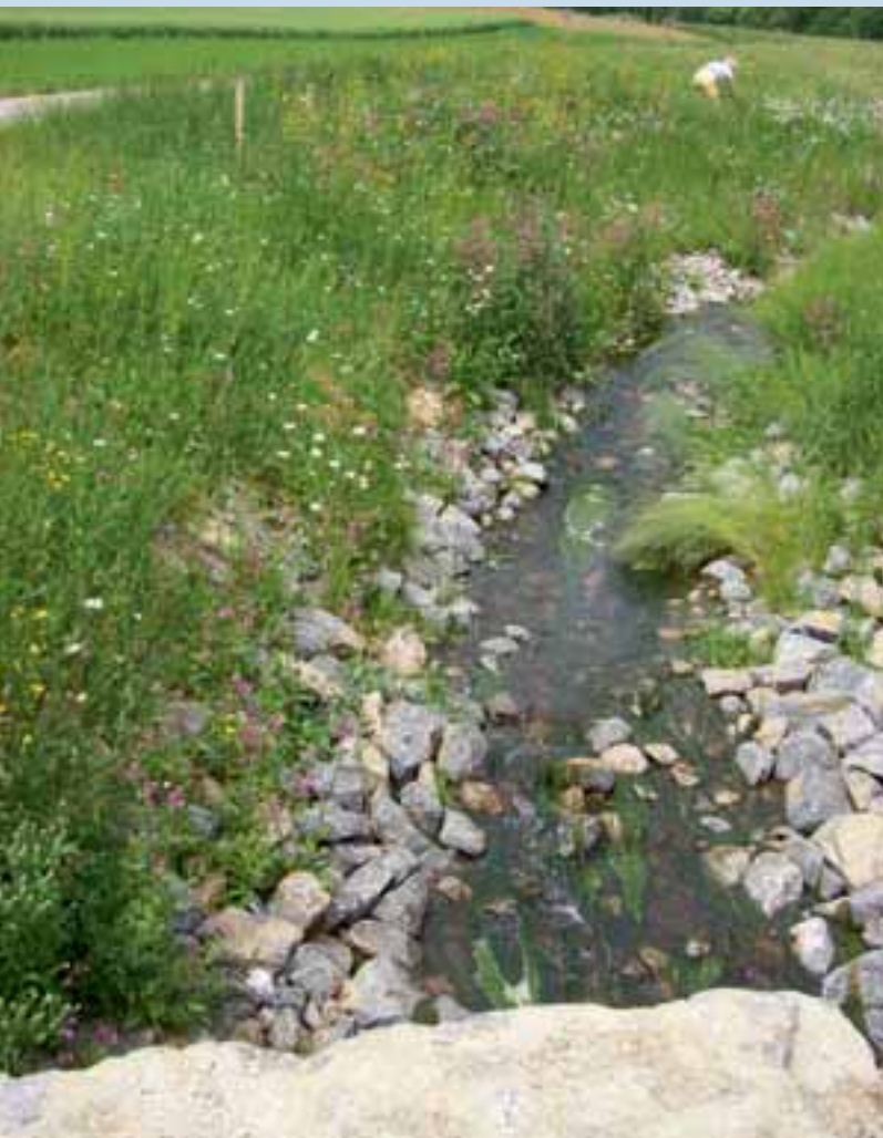
Renaturierter Eisengriffgraben bei Rutesheim
