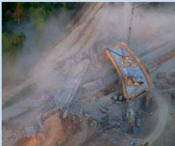
altes Bauwerk direkt nach der Sprengung Rechts: neues Bauwerk
