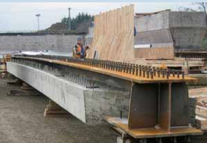
Preflexträger der Unterführung der S-Bahn nach der Anlieferung
