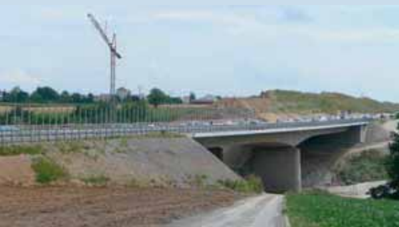
Ansicht der Eisengrifftalbrücke von Westen
