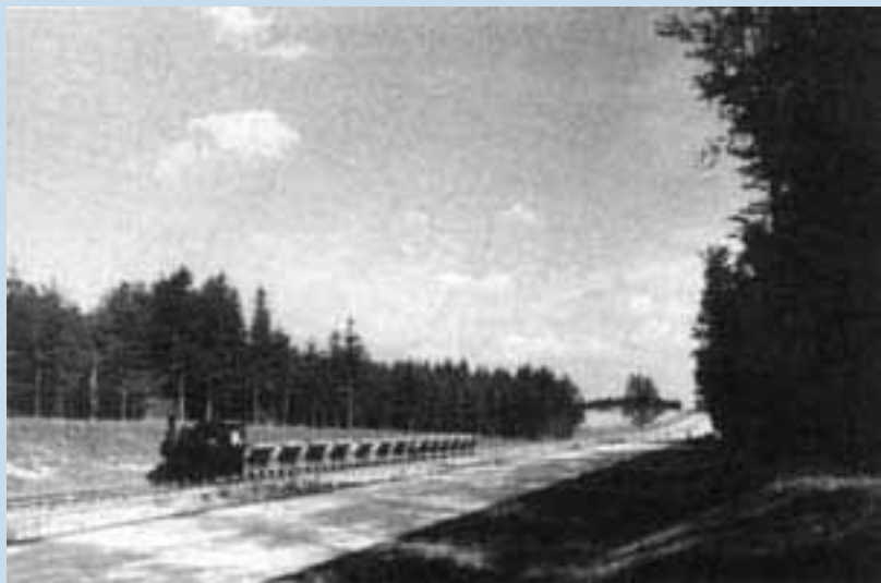
Stuttgart–Karlsruhe, Bau der Autobahn zwischen Perouse und Rutesheim
