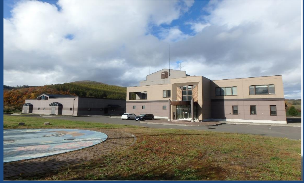
浄化センター写真
