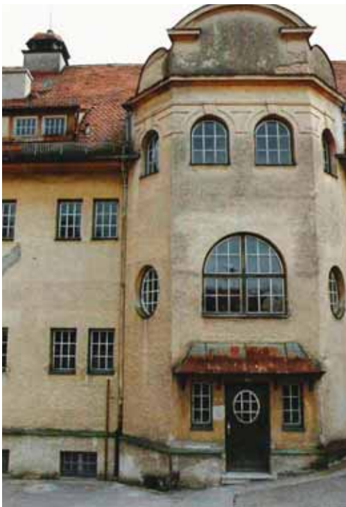
Lehrerwohnhaus vor der Renovierung: Örtliche Tradition der Baukunst
