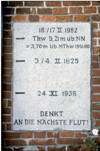
Abb. 4: Sturmflutmarken an den Gebäuden erinnern an vergangene Hochwasserereignisse.
