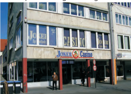
Abb. 73: Neue Straße 105, Spielhalle
