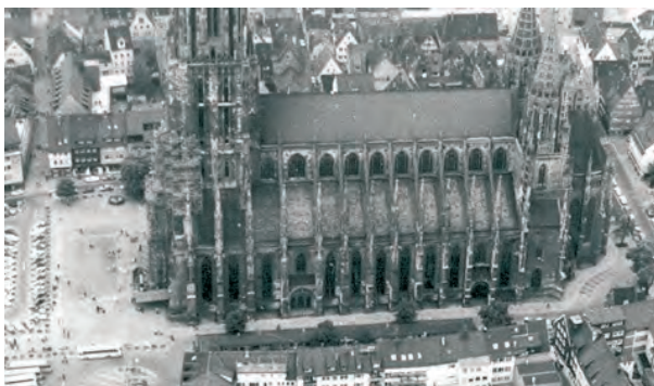
Abb. 17: Südlicher Münsterplatz (vor der Sanierung)
