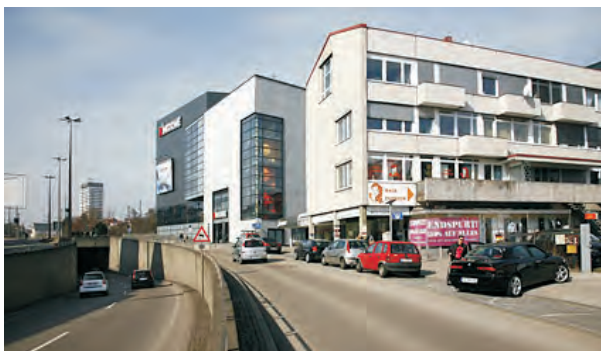
Abb. 8: Nördliche Neue Straße, 2010
