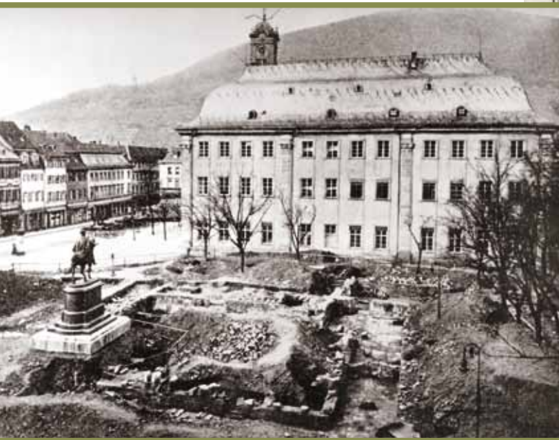
Abb. 2.03: Freilegung der Fundamente des Heidelberger Augustinerklosters unter dem heutigen Universitätsplatz vor der Alten Universität im Jahre 1912 (UAH, Pos I 03778).
