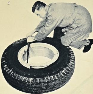
Das von Felgenhorn zu Felgenhorn ungeteilte Profil erlaubt beste Materialausnützung; die TRILEX-Felge ist deshalb trotz geringem Gewicht für höchste Beanspruchung geeignet und wird für schweren Einsatz bevorzugt.
