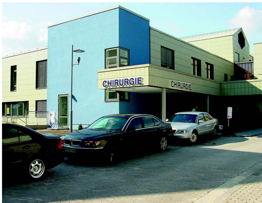
Der für 39 Millionen Euro errichtete Funktionsneubau der Chirurgie am Universitätsklinikum Homburg wird im November in Betrieb gehen.
