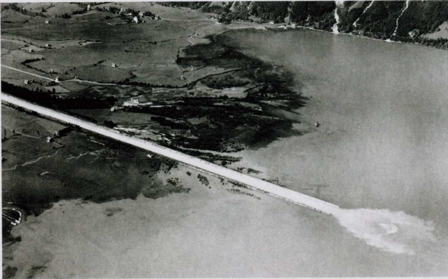
Die Reussmündung 1923: Der Kanal führte hinaus in den See, wo Kies und Sand in die Tiefe sanken. Dadurch verschwanden die Flachwasserzonen.
