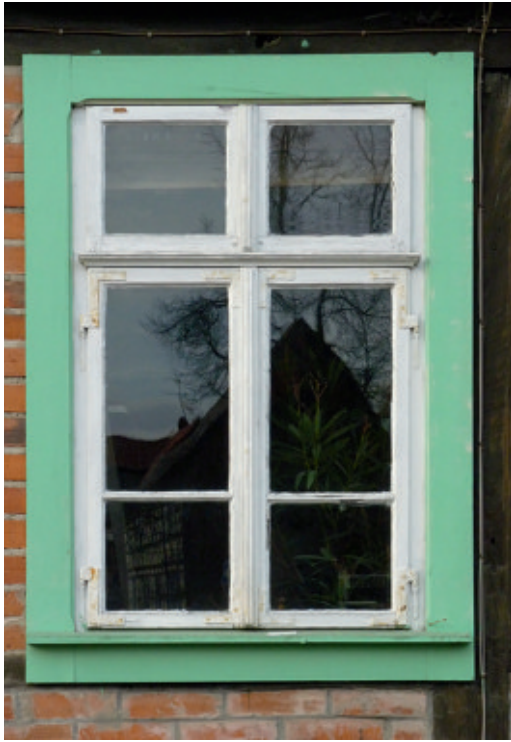
25 Nach außen öffnendes zweiflügliges Einfachfenster mit feststehenden Oberlicht (Oebisfelde-Weferlingen, Ortsteil Flecken, Wohnhaus)
