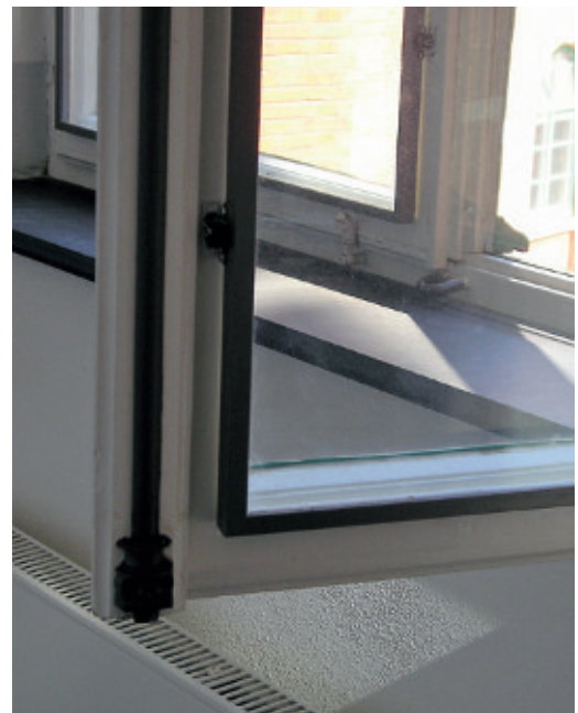
27–29 Einfachfenster können mit Hilfe von Vorsatzscheiben, rahmenlos oder gefasst, zu Verbundfenstern umgebaut werden. Die zusätzlichen Flügel, mit Dichtungen ausgestattet, werden mit Hilfe von Vorreibern, Klipsen oder Schrauben an den bestehenden Fensterrahmen angepresst. (Systemskizze Vorsatzscheibe innen mit Vorreiber gehalten / Blomberg, Schloss Reelkirchen / Esslingen, ehemaliges Schelztor-Gymnasium)
