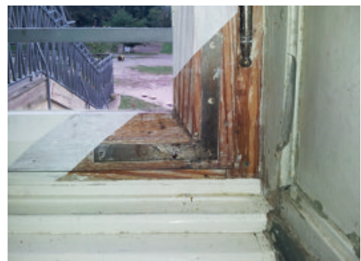
14+15 Anstricharbeiten an Fenstern in Leinöltechnik erfolgen in mehreren Arbeitsgängen, zwischen denen hinreichend Zeit zum Auftrocknen vorzusehen ist. (Homberg a. d. Ohm, Schloss und Wiesbaden-Dotzheim, Schloss Freudenberg)
