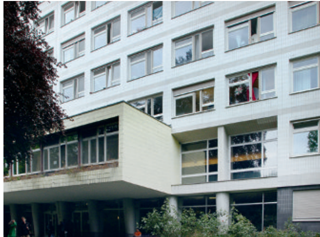
2 Die bauzeitlichen hölzernen Verbundfenster sind erscheinungsbildprägender Bestandteil der Fassadengestaltung. (Stuttgart, ehemaliges Bürgerhospital)
