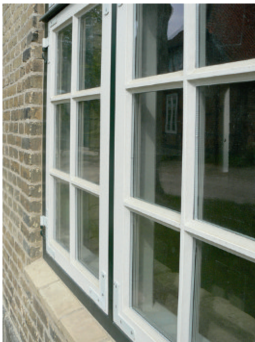
51+52 Systemskizzen zu Sprossierungen / Weisenhäuser Strand, Wohnhaus, Neufenster mit Wiener Sprossen
