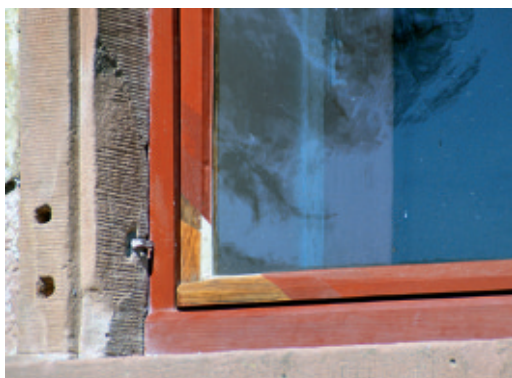
14+15 Anstricharbeiten an Fenstern in Leinöltechnik erfolgen in mehreren Arbeitsgängen, zwischen denen hinreichend Zeit zum Auftrocknen vorzusehen ist. (Homberg a. d. Ohm, Schloss und Wiesbaden-Dotzheim, Schloss Freudenberg)
