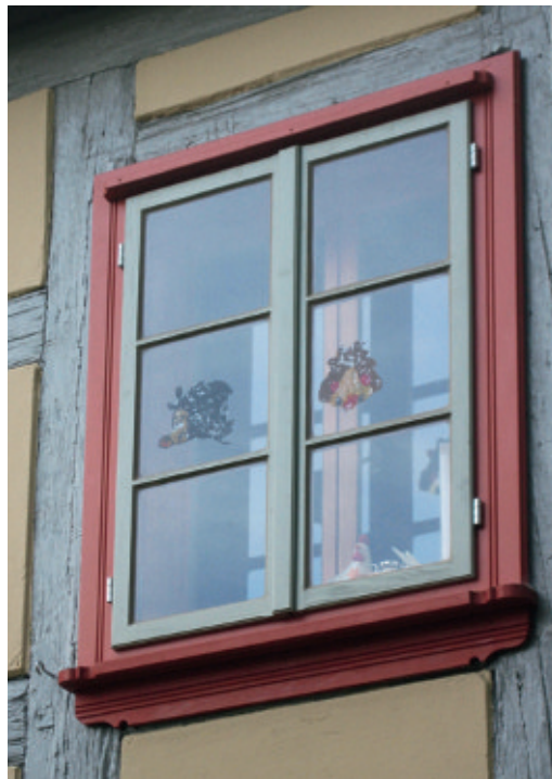
55-57 Neues Einfachfenster mit Isolierverglasung, neues Verbundfenster und neues Kastenfenster (Schwarzwald, Bauernhaus / Esslingen, Wohnhaus / Porschendorf, Sächsische Schweiz, Pfarrhaus)
