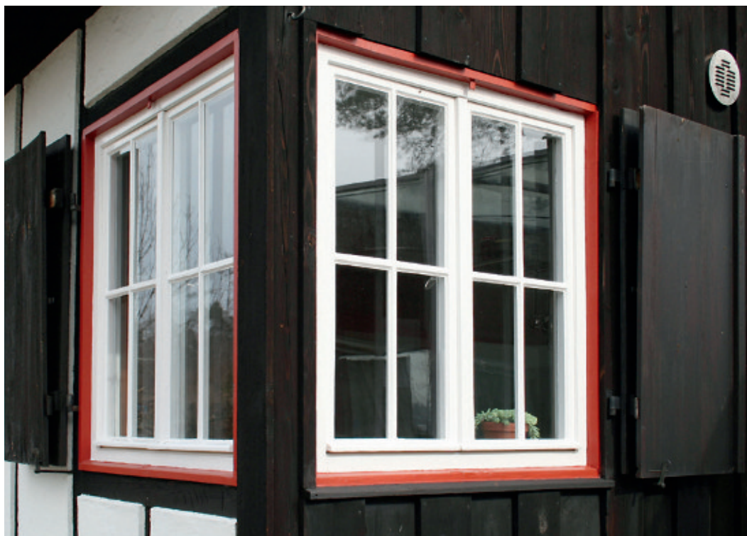
39 Verbundfenster der 1930er Jahre mit glasteilenden Sprossen im äußeren Fensterflügel, Gerlingen, Atelier- und Wohnhaus
