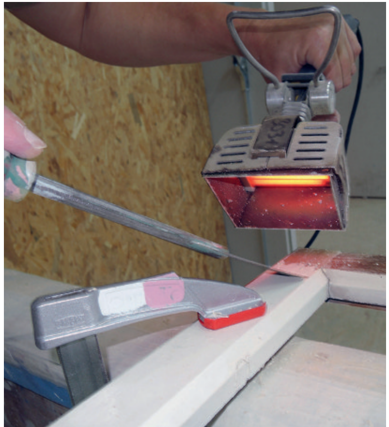
16 Altanstriche können mit Hilfe einer Wärmelampe angeweicht und mit einem Spachtel vorsichtig entfernt werden.
