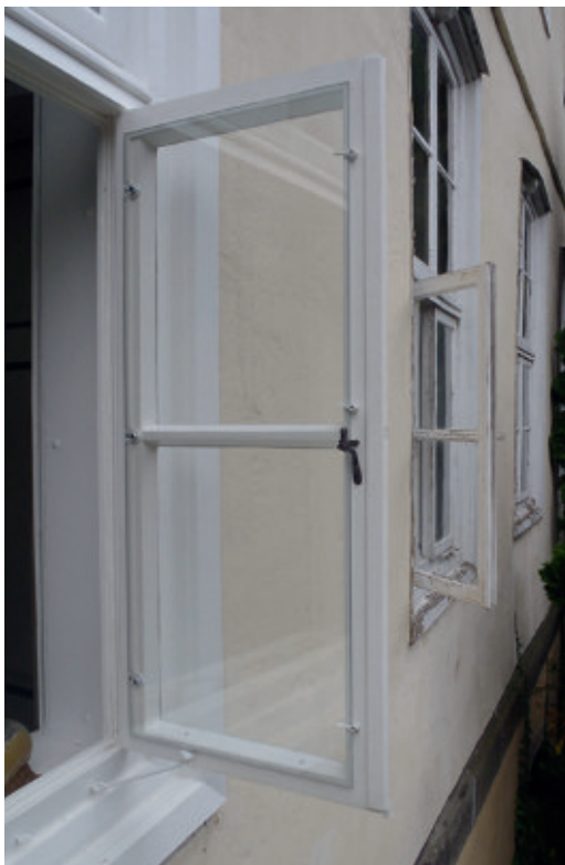
27–29 Einfachfenster können mit Hilfe von Vorsatzscheiben, rahmenlos oder gefasst, zu Verbundfenstern umgebaut werden. Die zusätzlichen Flügel, mit Dichtungen ausgestattet, werden mit Hilfe von Vorreibern, Klipsen oder Schrauben an den bestehenden Fensterrahmen angepresst. (Systemskizze Vorsatzscheibe innen mit Vorreiber gehalten / Blomberg, Schloss Reelkirchen / Esslingen, ehemaliges Schelztor-Gymnasium)
