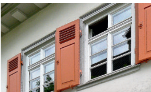
55-57 Neues Einfachfenster mit Isolierverglasung, neues Verbundfenster und neues Kastenfenster (Schwarzwald, Bauernhaus / Esslingen, Wohnhaus / Porschendorf, Sächsische Schweiz, Pfarrhaus)
