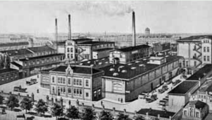
1892 eröffnete die Gesellschaft für Linde's Eismaschinen in Hamburg ein großes Werk für Lebensmittelkühlung und Eiszerzeugung.
