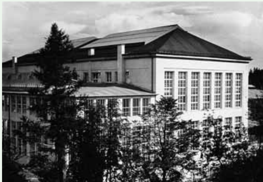
Zerstörte Werksanlagen in Höllriegelskreuth vor (oben) und nach dem Wiederaufbau (unten; um 1950).
