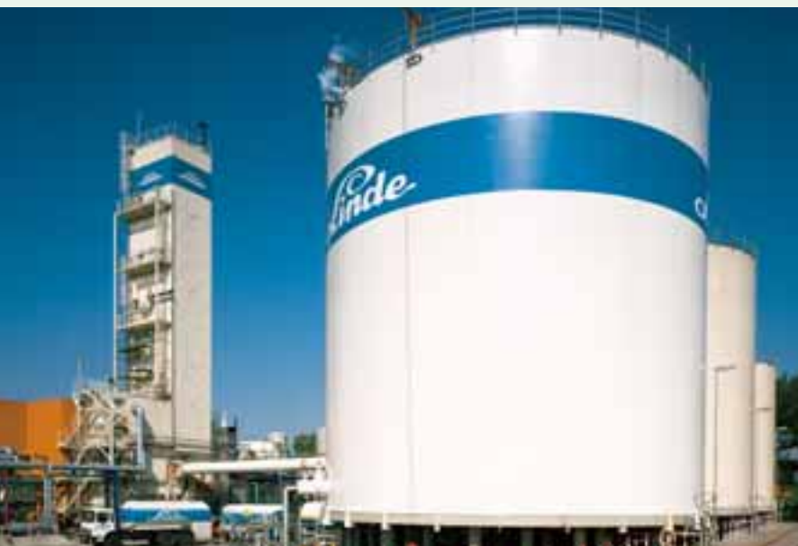
Linde-Gasezentrum in Herne, Deutschland (1982).
