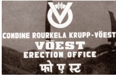
VÖEST-Baubüro in Rourkela, Indien.
