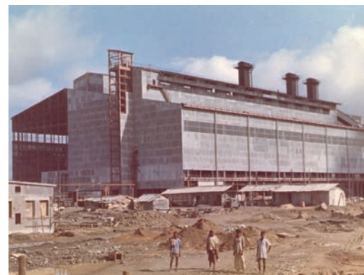
Bauphase LD-Stahlwerk Rourkela, Indien (Foto: Geschichteclub Stahl).
