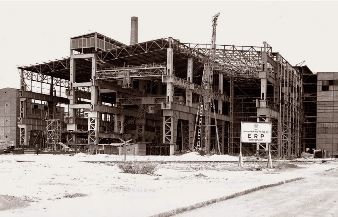
LD-Stahlwerk 1 der VÖEST in der Bauphase.
