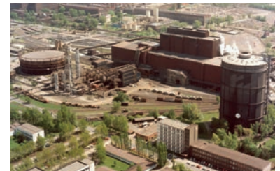
LD-Stahlwerk 3 am Standort Linz 1990.
