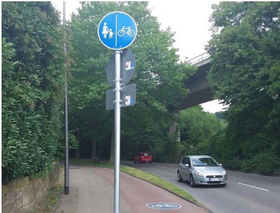
Abb. 55: Baulicher Radweg im Zweirichtungsverkehr (Industriestraße) [Quelle: SVK]
