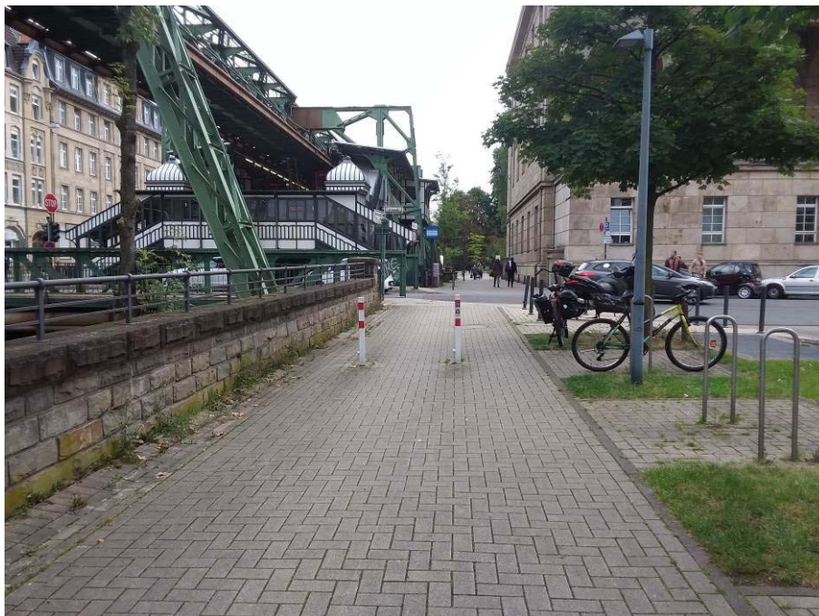
Abb. 56: Beispiel für Hindernisse im Lichtraumprofil: Hartmannufer [Quelle: SVK]
