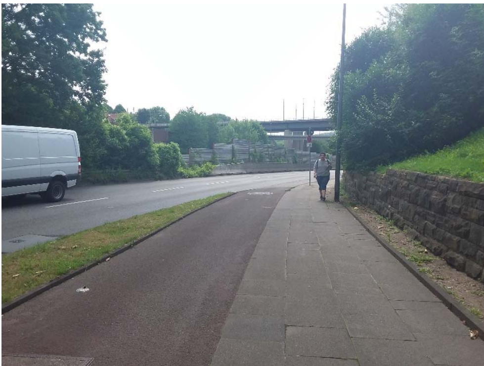
Abb.: Baulicher Radweg ohne Sicherheitstrennstreifen zum Gehweg (Industriestraße) [Quelle: SVK]
