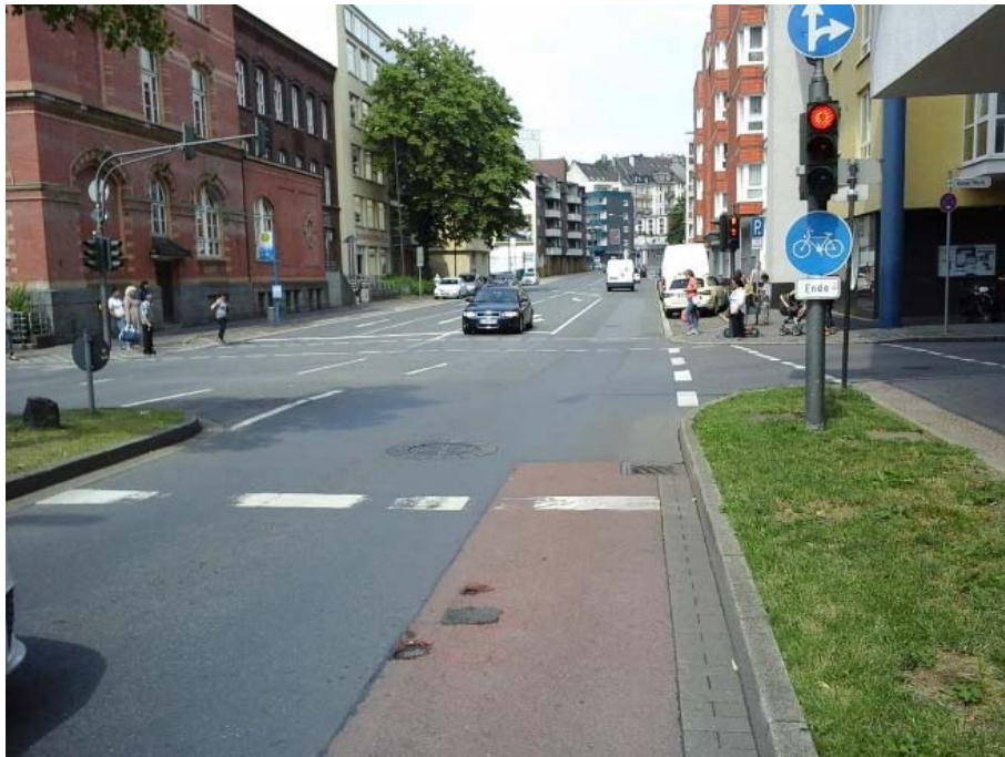
Abb. 59: Beispiel für mangelhafte Überleitung: Bachstraße [Quelle: SVK]
