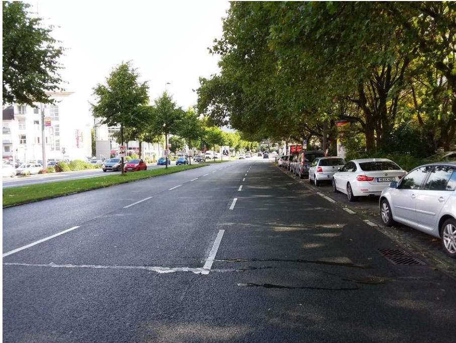
Abb. 62: Beispiel für ungesicherte Streckenabschnitte auf dem Radverkehrsnetz 2018 der Stadt Wuppertal (Bundesallee) [Quelle: SVK]
