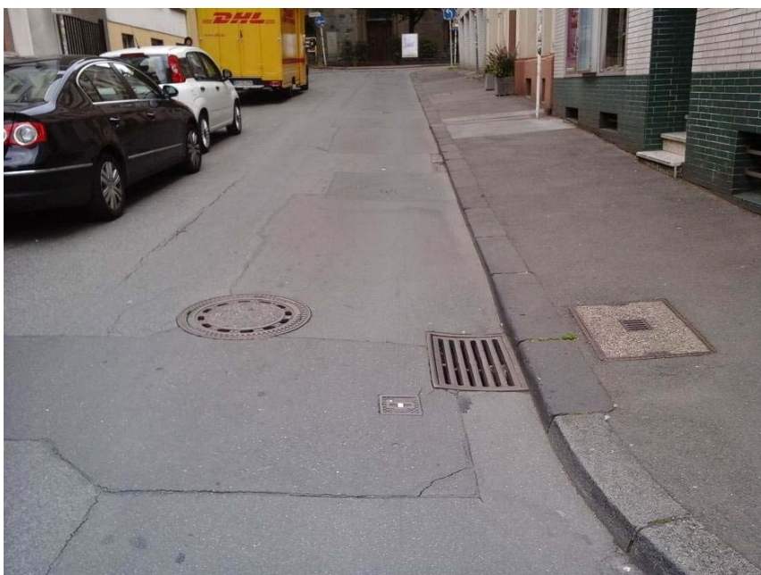
Abb. 65: Sicherheitsmangel (Straßeneinlauf parallel zur Fahrtrichtung) und Komfortmangel (Oberfläche) auf dem Radverkehrsnetz 2018 der Stadt Wuppertal (Friedrichstraße) [Quelle: SVK]
