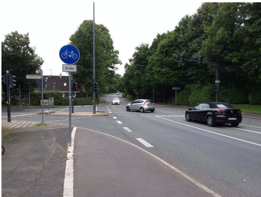
Abb. 58: Beispiel für mangelhafte Überleitung: Westfalenweg [Quelle: SVK]
