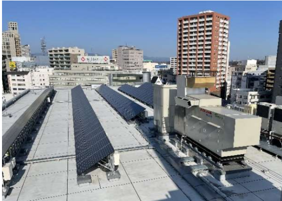
左：屋上に設置した発電機及び太陽光パネル 右：地下タンク（容量 50,000L）
