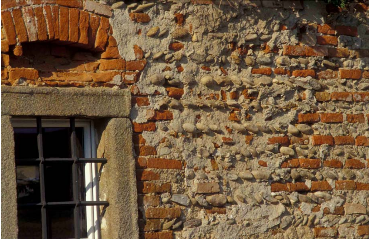
Foto 15: Alte Mauer eines Vierkanthofs aus Ziegel und Flußkiesel, einem Baumaterial aus der Gegend
