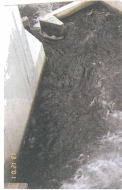
Bei Richtungsänderungen entstehen größere Ruhebecken
