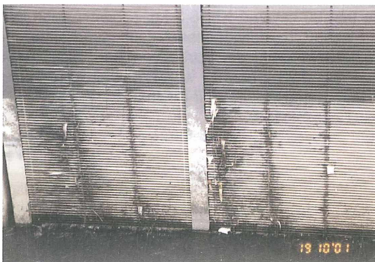
Fischpass Iffezheim: Aalstücke in den Beruhigungslamellen für das abströmende Wasser aus der Lockstromturbine (Fotos: P. Jäger)
