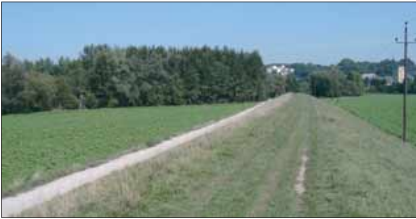
Abb. 16: Der geradlinig verlaufende Hochwasserschutzdamm trennt das Augebiet vom umliegenden Kulturland. Er ist zwar landschaftlich keine Augenweide, aber zum Schutz vor Hochwasser trotzdem von Bedeutung und auch ökologisch durchaus nicht zu verachten: An der südexponierten Böschung befindet sich einer der wenigen Magerwiesenstandorte des Linzer Südens. Im Hintergrund ist bereits das Schloss Ebelsberg zu erkennen. Foto: W. Bejvl
