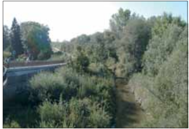
Abb. 7: Feilbach und Strobl-Mühlbach auf der anderen Seite des Damms begleiten den Audamm, der das Ortszentrum von Ebelsberg vor Hochwässern schützen soll. Auf der Dammkrone verläuft ein asphaltierter Geh- und Radweg. Foto: W. Bejvl
