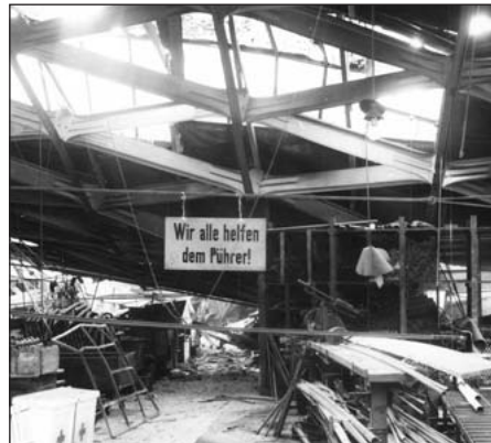
Werkhalle des Horch-Werkes nach dem Bombenangriff vom 1. November 1944. Stadtarchiv Zwickau: Fotosammlung, Urheber: August Horch Museum Zwickau
