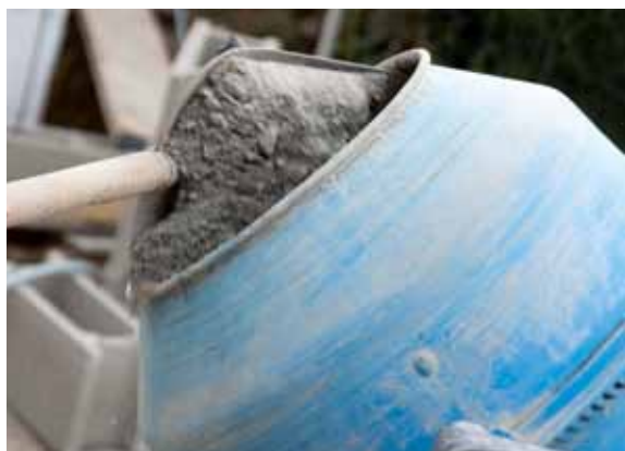
Abb. 17: Zement in den Mischer geben.
