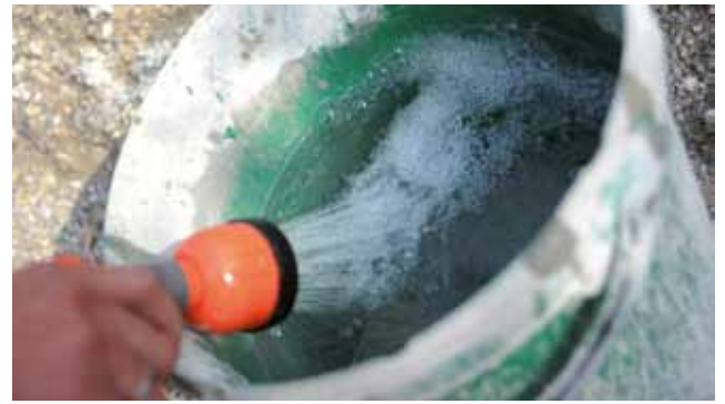
Abb. 5: Sauberes, klares Wasser zum Mischen des Betons verwenden.
