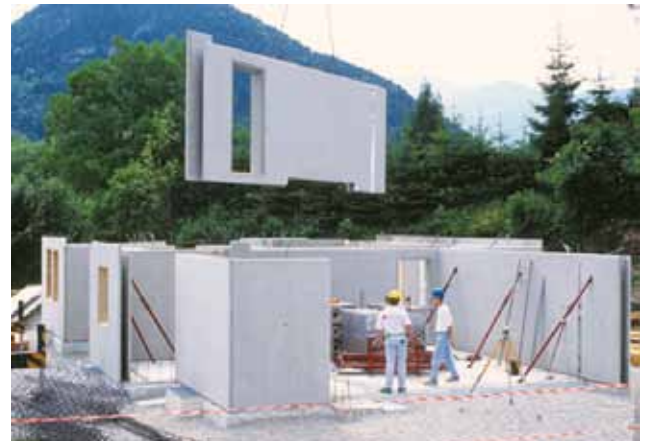
Abb. 27: Kranabladung von Betonfertigteilen
