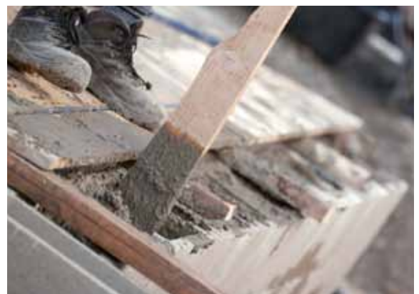
Abb. 21: Sorgfältige Verdichtung ist wichtig.
