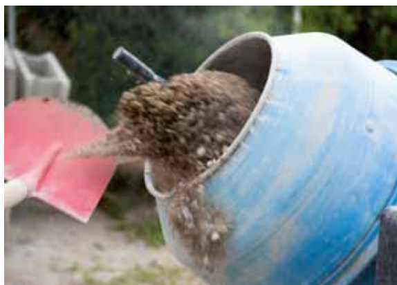
Abb. 16: Geringe Menge Korngemisch in den Mischer geben.
