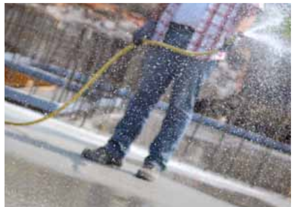
Abb. 23: Besprühen der frischen Betonoberfläche mit Wasser
