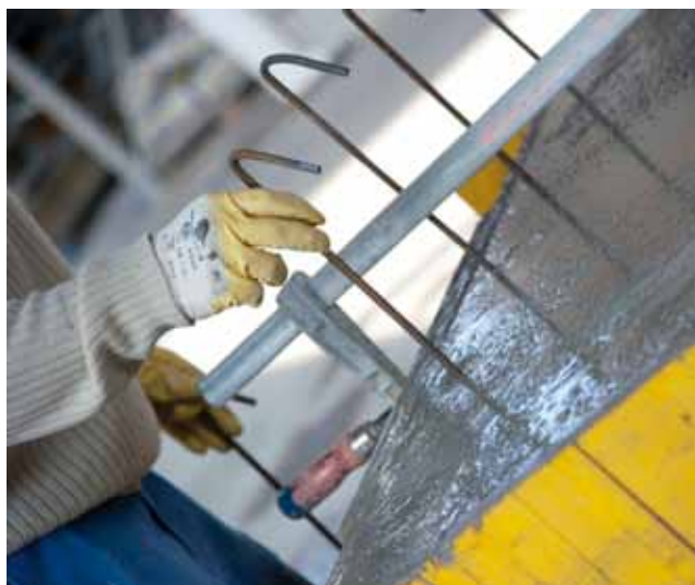
Abb. 22: Steckeisen gewährleisten die Verbindung zwischen Betonierabschnitten.
