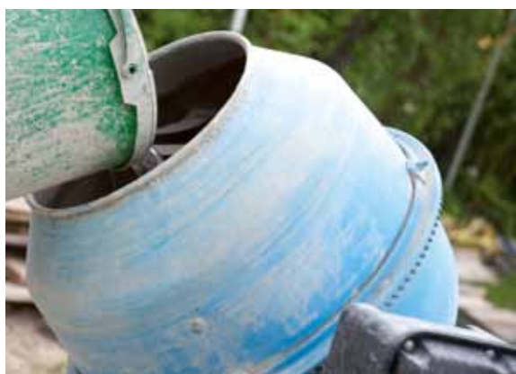
Abb. 15: Wasser in den Mischer geben.
