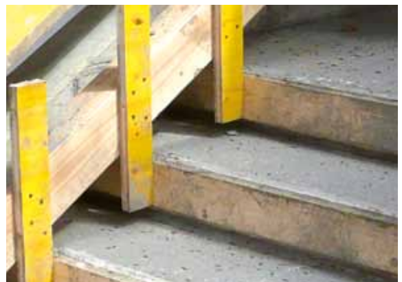
Abb. 24: Schalungen so lange als möglich belassen.
