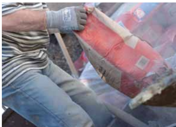
Abb. 14: Öffnen des Zementsacks.
