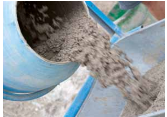
Abb. 18: Frischbeton mit einer Scheibtruhe transportieren.
