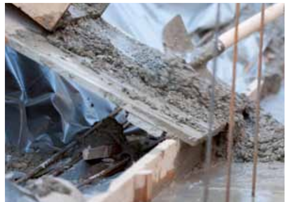
Abb. 20: Frischen Beton sofort verarbeiten.
