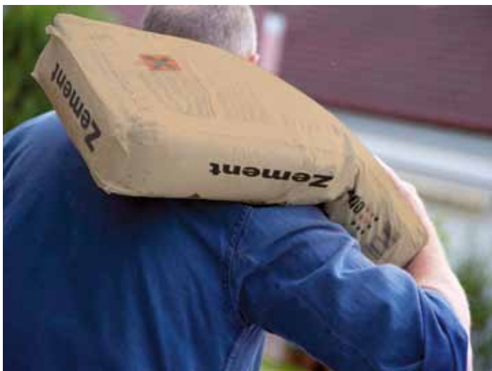
Abb. 2: Zur leichteren Handhabung ist das Sackgewicht bei Zement auf 25 kg festgelegt.
